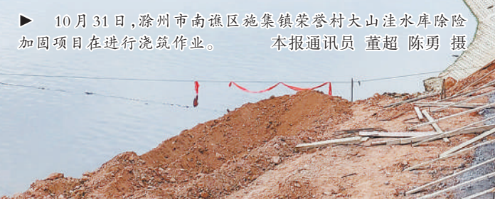
▶ 10月31日,滁州市南谯区施集镇荣誉村大山洼水库除险加固项目在进行浇筑作业。 本报通讯员 董超 陈勇 摄
