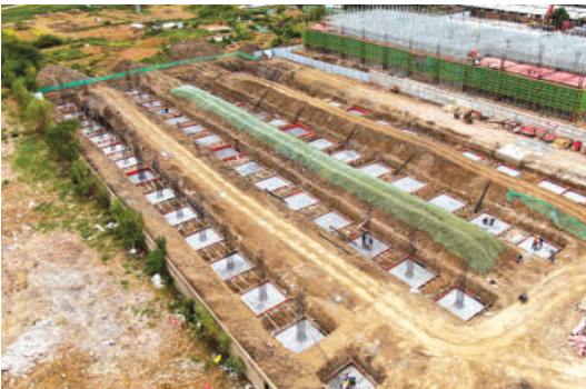
安徽长丰(双凤)经开区合肥协力液压科技有限公司项目建设现场。(资料图片)
