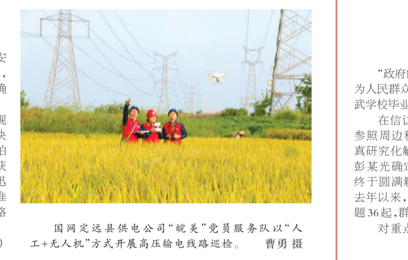
国网定远县供电公司“皖美”党员服务队以“人工+无人机”方式开展高压输电线路巡检。 曹勇摄
