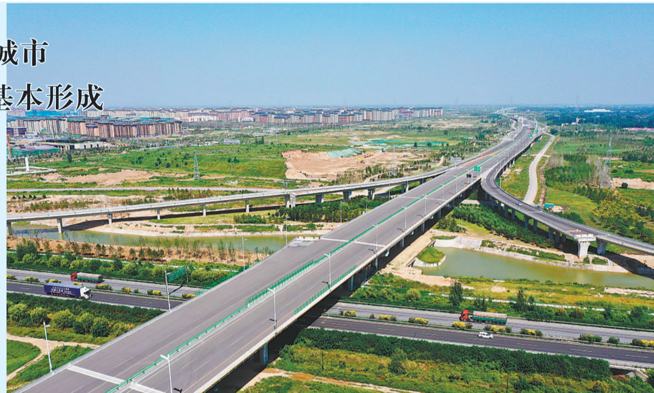
河北雄安新区内岳岳大街与京雄高速连接线(9月2日摄，无人机照片)。记者从河北雄安新区管委会了解到，目前雄安新区内部城市骨干路网体系基本形成，雄安新区城市框架逐步拉开，为大规模开发建设提供了有力支撑。
