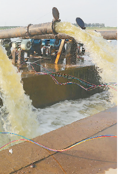
8月18日,当涂县护河镇杨湾排涝站临时架设的水泵正在抽取长江支流姑溪河水进入内河。面对持续干旱,当涂县启动抗旱Ⅳ级应急响应,在全县沿河设置83处临时抗旱取水点,安装抽水机(泵)366台套6320千瓦,日均提水量约480万立方米,灌溉受旱农田43.6万亩。 本报通讯员 王玉实 尹秀忠 摄
