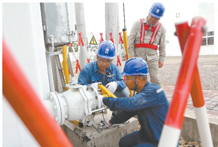
7月29日,马鞍山供电公司采用不停电方式检修220千伏上湖变电站主变设备,确保变电站连续可靠运行,保障夏季城乡生产生活电力供应。
