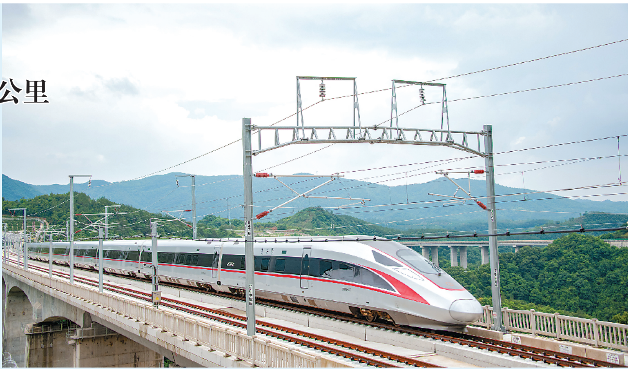
6月20日,列车驶过郑渝高铁白洛河双线大桥(无人机照片)。当日,郑州至重庆高速铁路襄阳东至万州北段开通,郑渝高铁实现全线贯通运营。新华社发(伍志尊 摄)
