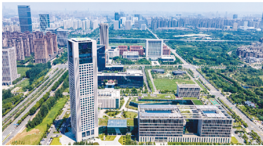
位于合肥滨湖新区的建行安徽省分行办公大楼。
