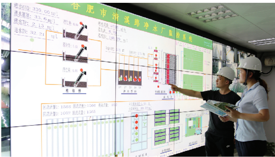
安徽省分行为污水处理及再生利用企业提供信贷支持。图为安徽国祯环保节能科技股份有限公司合肥清溪净水厂中控室。
