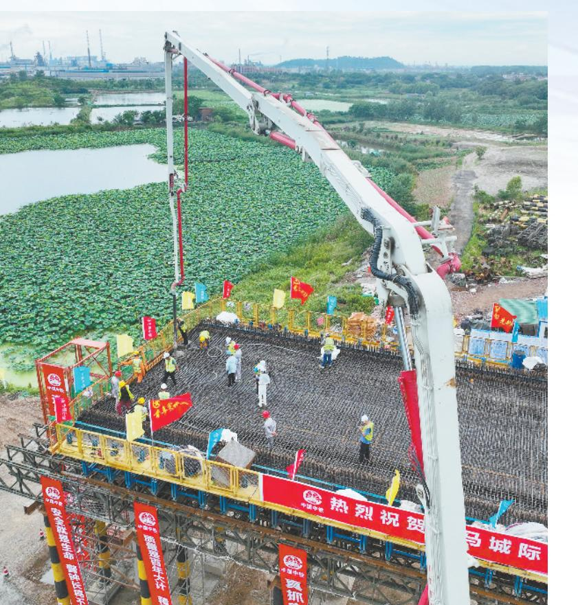
6月30日,在马鞍山市花山区,中铁四局施工的宁马城际铁路全线首孔现浇梁浇筑完成。
