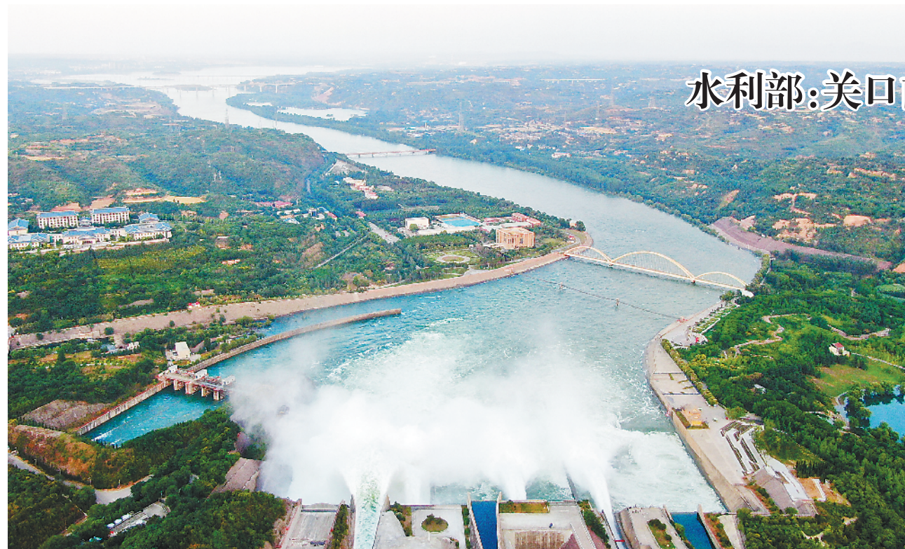
6月24日在河南济源拍摄的小浪底水利枢纽工程调水调沙现场(无人机照片)。近日,水利部黄河水利委员会联合调度万家寨、三门峡、小浪底水库,实施2022年汛前黄河调水调沙。
