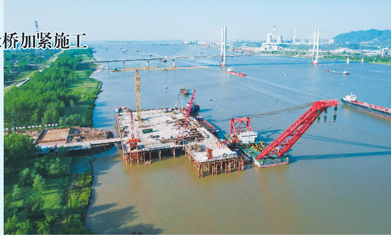
4月21日，G3铜陵长江公铁大桥主墩施工现场，旋挖钻机、挖掘机等大型机械在加紧施工。铜陵长江公铁大桥工程是铜陵市加快融入合肥都市圈、长三角一体化高质量发展的重要工程。目前，大桥主塔墩钻孔桩施工完成，比计划工期提前30天。
