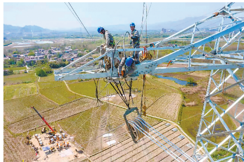
4月12日,绩溪高铁宁国段500千伏电力线路迁改工程顺利完成。该工程拆除旧铁塔6基,线路1.735千米,在原址附近新组立铁塔6基,新建线路1.625千米。工程完工后,为推进绩溪高铁建设打下基础。
