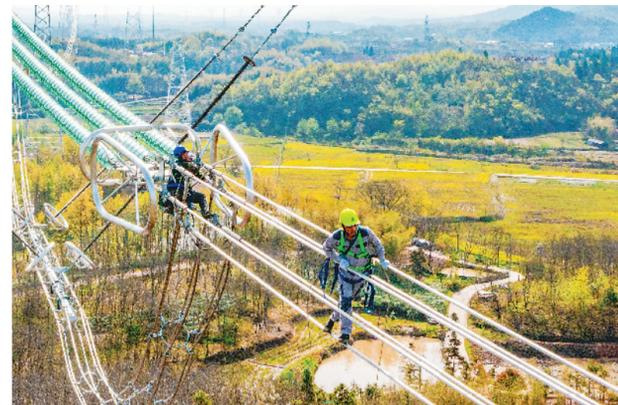
近日,国网六安供电公司、安徽送变电公司等建设单位在六安市霍山县下符桥镇境内,对白鹤滩—江苏±800千伏特高压直流输电线路安徽段进行首次“走线验收”,标志线路进入验收阶段。白鹤滩—江苏±800千伏特高压直流输电工程是国家“西电东送”战略的骨干通道,其中安徽段全长361.8公里。
