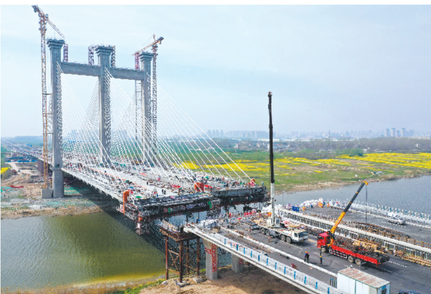
4月4日，蒙城县涡河五桥建设工地，大桥建设者在施工。清明小长假期间，大桥建设者坚守岗位，有序施工，确保今年5月主跨如期合龙。 本报通讯员 胡卫国 摄
