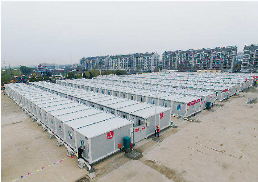
3月19日，经过5天不分昼夜的紧张奋战，当涂县临时隔离点一期建成。该临时隔离点位于当涂县姑孰镇焦家社区附近的老汽车站，252间隔离房均为装配式集装箱，配备空调、热水器、整体淋浴卫生间、床及床上用品等。
