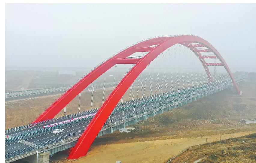
日前,历时两年多的紧张建设,由中铁十局承建的引江济淮 G3 合铜黄高速特大桥顺利通车,为引江济淮河道的早日通水通航提供坚实保障。 本报记者 李博 本报通讯员 张倩 摄
