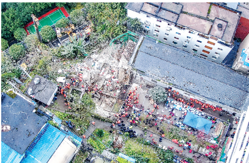
1月7日,重庆市武隆区凤山街道办事处食堂发生坍塌,疑似食堂燃气泄漏燃爆。据现场应急指挥部消息,截至7日24时,26名被困人员救出,其中16人经抢救无效死亡,1人伤情危重,伤者已送往医院救治。图为1月7日拍摄的重庆市武隆区凤山街道办事处食堂坍塌现场(无人机照片)。新华社记者 黄伟 摄
