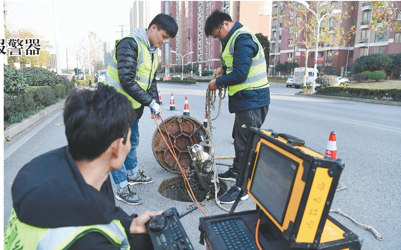
◀ 管道机器人对地下管网情况可以实时传输。
