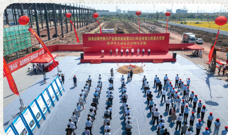
加快战略性新兴产业集群建设暨全省第九批重大项目集中开工马鞍山分会场在当涂举办。
