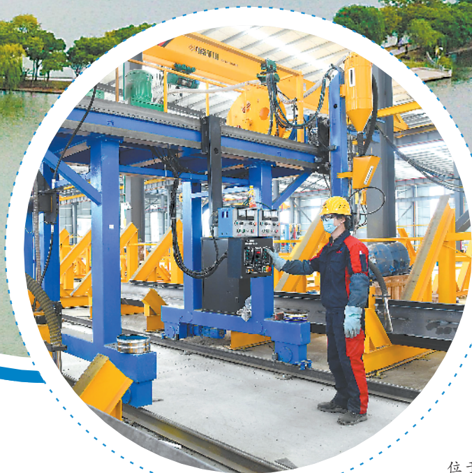
位于铜陵市的安徽浙建钢结构有限公司生产车间，工人在生产线上忙碌着。
