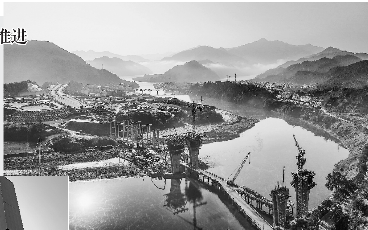
12月7日，宣绩铁路首孔跨皖赣线框架墩顺利吊装并精准落位，安全正点完成节点目标。宣绩高铁正线全长111.701千米，是长三角城际轨道交通网中骨干线路、华东地区重要的旅游通道，是苏、皖、赣、粤通道的重要组成部分。
