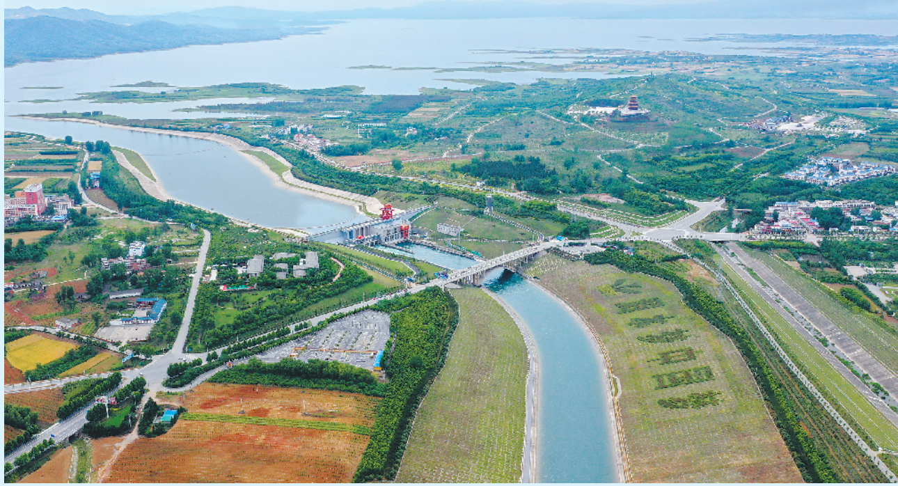
这是在河南省南阳市浙川县拍摄的南水北调中线工程陶岔渠首(5月20日摄,无人机照片)。新华社记者 李嘉南 摄
