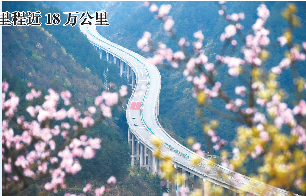
图为贵州黔南至剑河高速公路剑河县岑松镇段桥梁。新华社记者 杨文斌 摄
