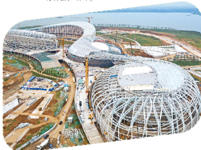
正在施工中的滁州奥体中心。
