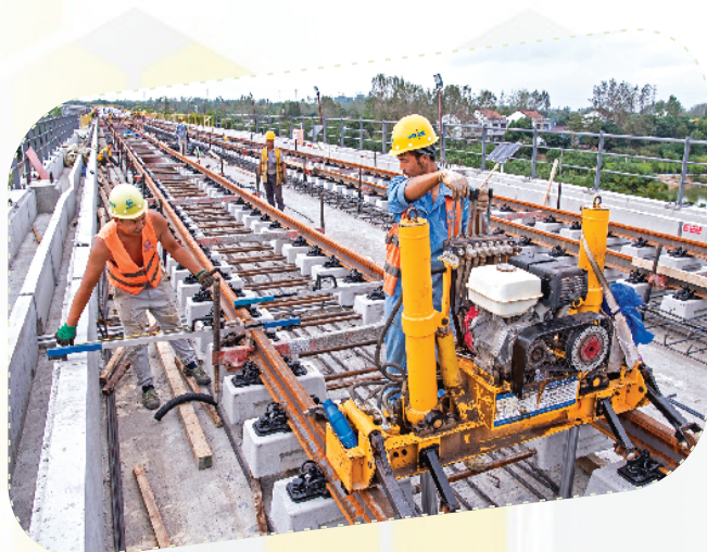
滁宁城际铁路来安水口镇境内，工人们正在对铁轨排进行粗调。
