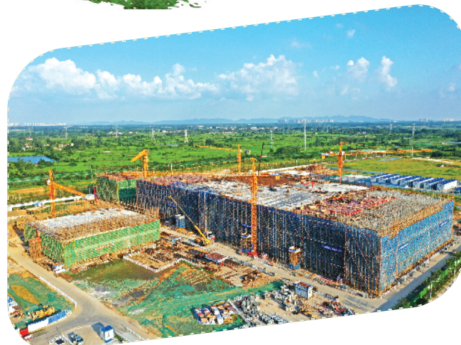
中新苏滁高新区先进半导体封装材料生产项目。
