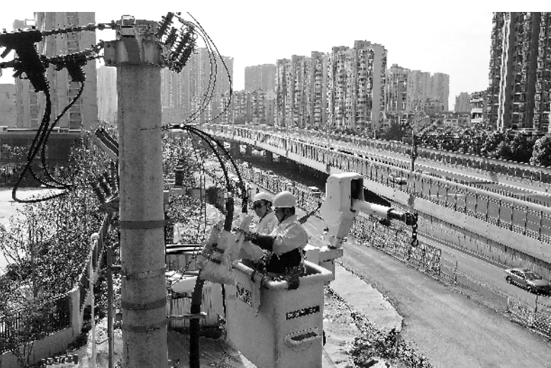
7月20日,在合肥市畅通二环工程电力改造现场,合肥电力安装有限公司工作人员首次采用10千伏中压发电车,通过转供负荷不停电作业方式完成畅通二环北环(中段)杆线撤除,实现了千余户群众和12户高压企业用户无感停电。
