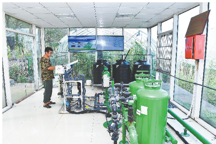
▶ 7月21日,安徽朗坤农业有限公司,技术人员在水肥一体智慧物联网控制室里操作机器。
