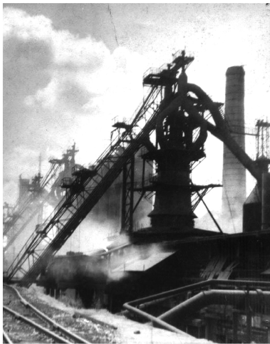
1953年9月16日18时5分,马鞍山铁厂2号高炉顺利流出了第一炉铁水,改变了华东地区有矿无铁的历史。(资料照片)
