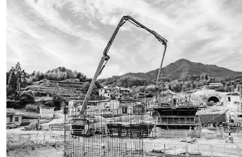
6月5日,由中铁二十一局建设的宣绩铁路站八角亭大桥首个墩身顺利浇筑完成,标志着项目桥梁工程进入了新的阶段。宣绩铁路是芜湖-宣城-景德镇(皖赣新双线)铁路的重要组成部分。目前,该项目段所属隧道、桥梁均已进场,工程预计2024年8月完工。
