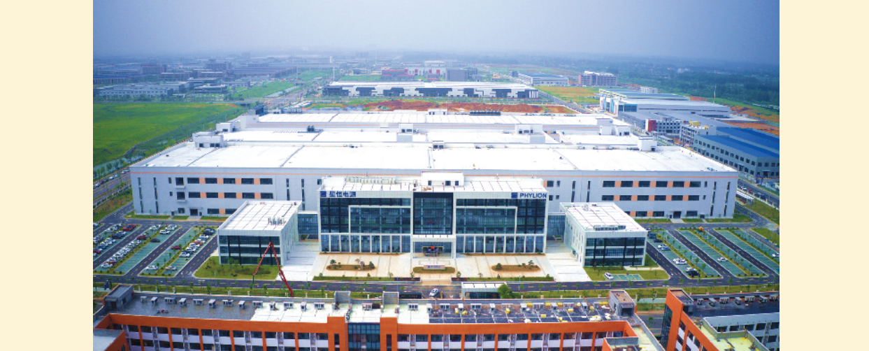
位于滁滁高新区的星恒动力电池项目。
