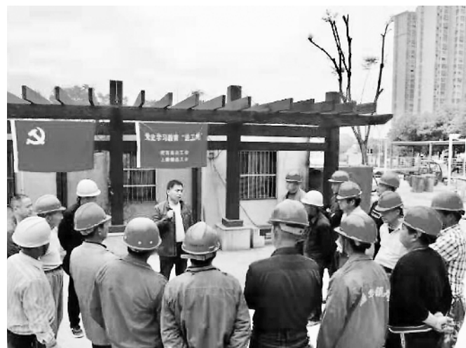
4月20日,在肥西县上派镇张郢一期安置小区综合改造工程工地上,全国林业劳动模范、全国农村致富带头人、全国十大苗木经纪人刘义旭为参与小区改造项目的一线建设者们讲党史。 本报通讯员 李强 本报记者 胡妮莉 摄
