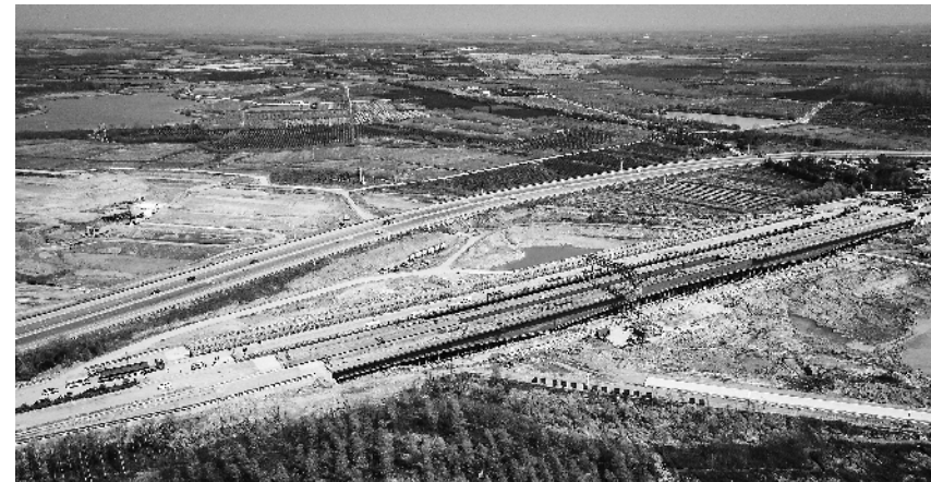
3月25日拍摄的位于合肥市蜀山区小庙镇境内正在施工的引江济淮312合六叶公路桥。该项目是引江济淮最大跨度的连续钢箱梁桥,全长280米,总用钢量达1.6万吨,桥面总宽52.5米。目前主体工程已经完工,预计在5月份建成通车。
