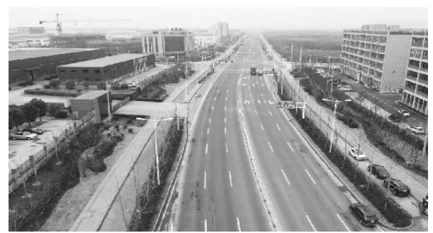
即将完工的肥西经开区玉兰大道绿化提升项目。
