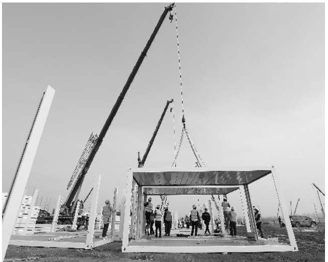
1月14日，工人在石家庄市集中隔离点建设工地组装集成房屋。目前，集中隔离点工程地面硬化、水电等基建工程和集成房屋拼装已全部展开。3000套集成房屋正由唐山市陆续运抵正定县。
