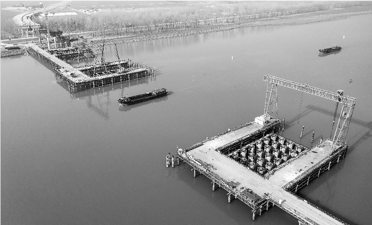
1月3日,建设中的五河 S313 淮河特大桥。该特大桥全长 2017 米,为我省首座波形钢腹板 PC 组合箱梁矮塔斜拉桥,建成后有效优化和完善区域路网结构。
